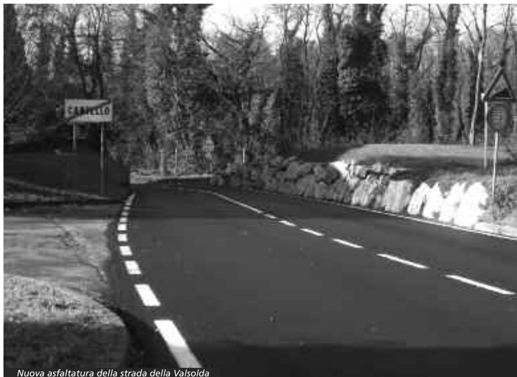
Nuova asfaltatura della strada della Valsolda
