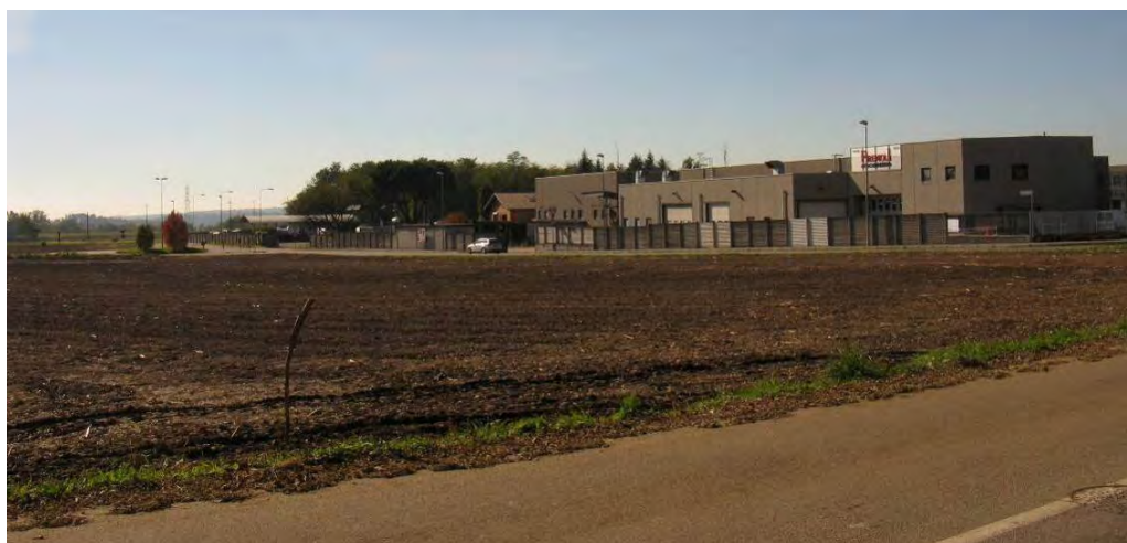
foto 9: Inserimento della zona industriale nell'ambito agricolo
