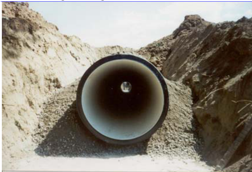
scavo in trincea con rinterro
