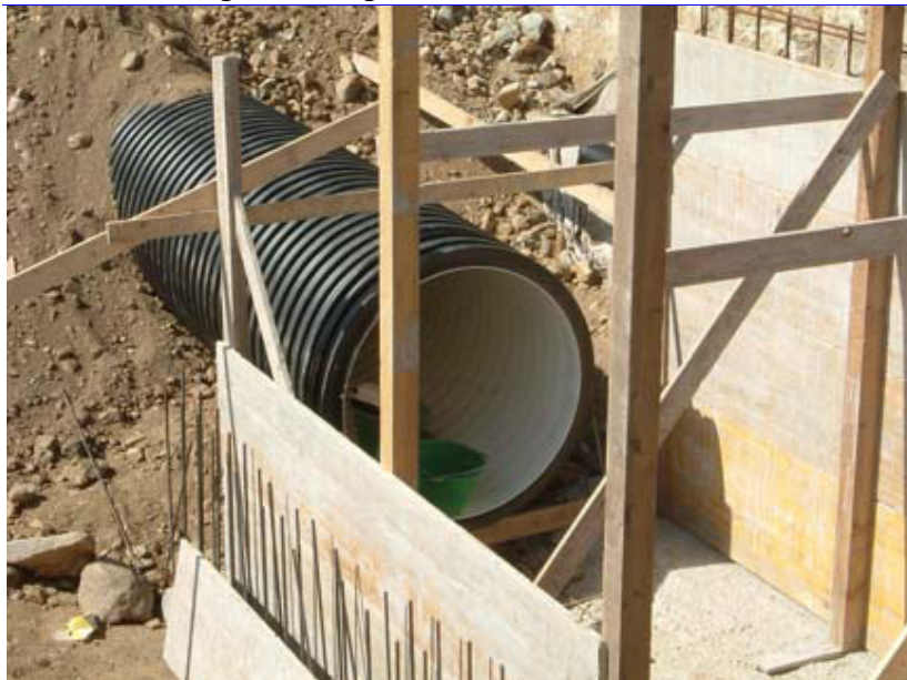
scavi in trincea con sostegno delle pareti
