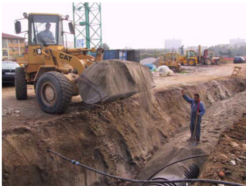
scavo in trincea con rinterro
